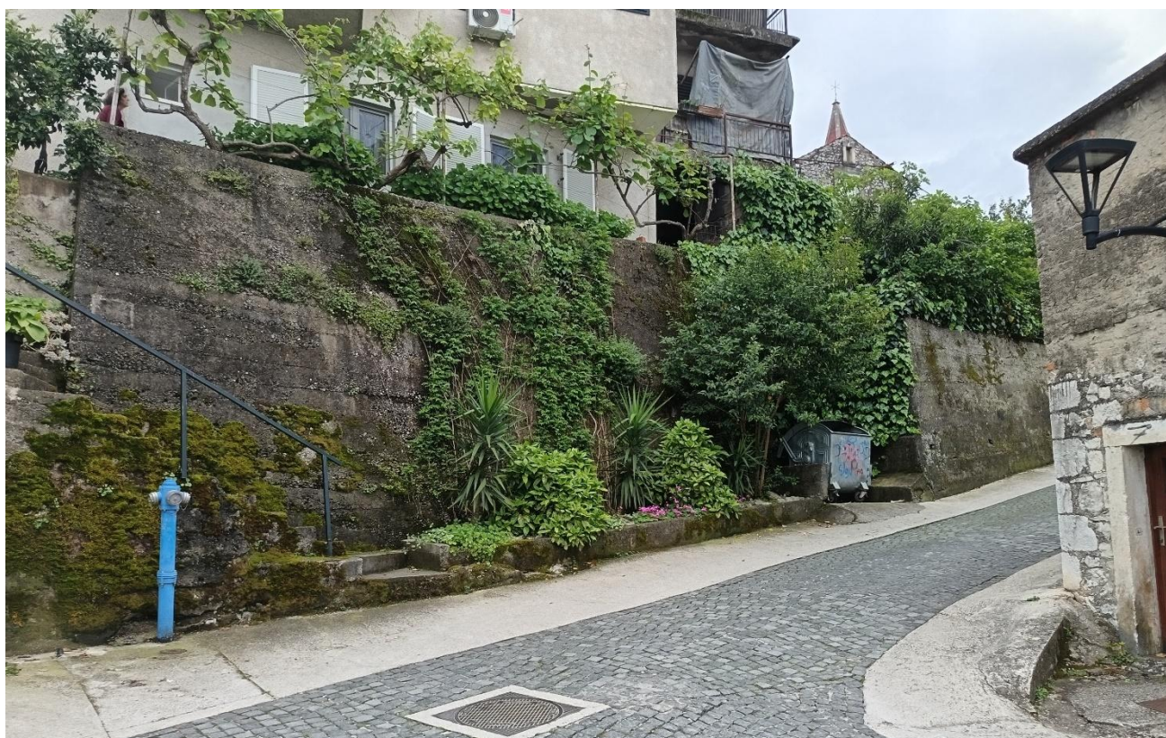
Fotografija 48. Ozelenjeni potporni zid u povijesnom dijelu grada Metkovića od strane lokalne zajednice (Izvor: terenska istraživanja)
