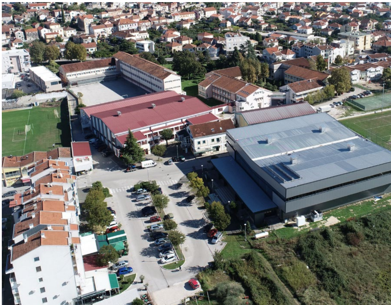
Fotografija 4. Gradska sportska dvorana u Metkoviću (Izvor: Brošura, Energetska obnova Gradske sportske dvorane u Metkoviću, https://grad-metkovic.hr/wp-content/uploads/2020/10/Brosura_Dvorana.pdf )
