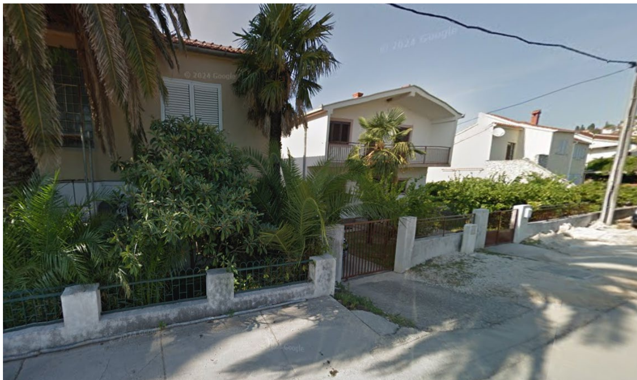
Fotografija 19. Rahljija stambena izgradnja u podgrađu (Ulica Petra Krešimira IV., bliže središtu grada) (Izvor: GoogleMaps)
